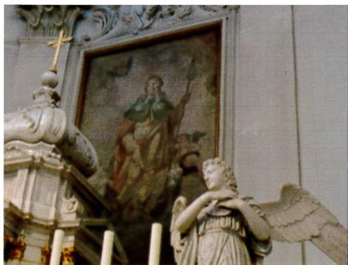
**7) Altare maggiore:** degrado generalizzato delle superfici per depositi incoerenti e coerenti; decadimento delle stuccature e delle zone di raccordo tra superfici con evidenza di fessurazioni; quasi totale assenza di pellicola di protezione delle superfici marmoree.
